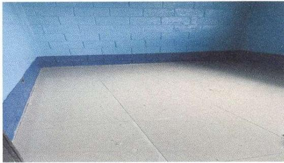
FOTO 3: Sustrucción de piso de torta de concreto por porcelanato, módulo No. 2
